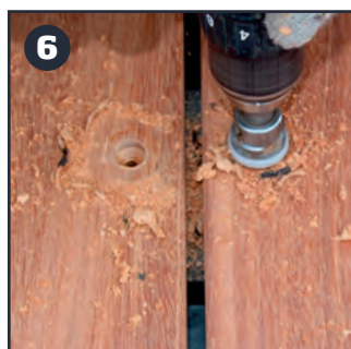
Forboring af huller til propper
