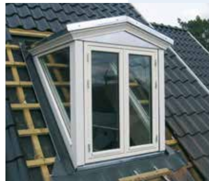
Frontvindue isættes og tagbeklædning lægges omkring kvist.
