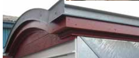
Knæk på tag, bræddespejl og udhæng
