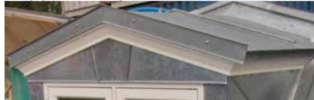
Zinkspejl og gesimslister
