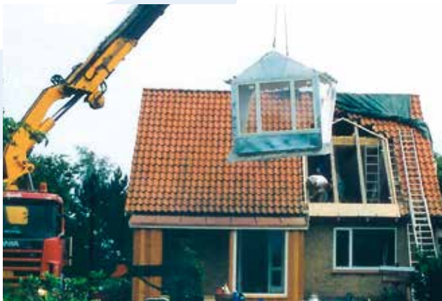
Præfabrikerede kviste monteres på én dag.
