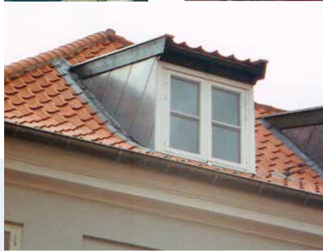
Specielle krav: Koblede vinduer, slanke flunke samt blyvinger.
