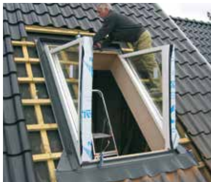
Flunke opsættes og medfølgende inddækning lægges omkring.
