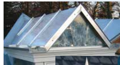
Zinkspejl og gesimslister
