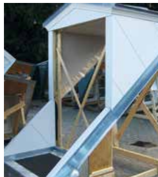
Flunk udført i hvid aluminium med blindfalse. Også den indvendige flunk i altankviste kan beklædes med hvid alu.
