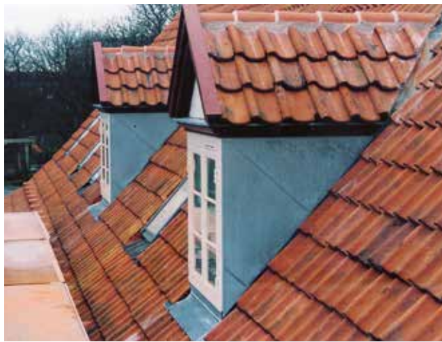
Specielle krav: Koblede vinduer med tømmerkarm, hjørnebåndshængsler og trægavl
