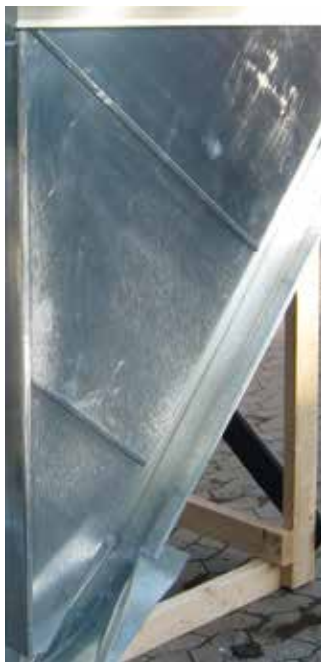
Traditionel zinkflunk med blindfalse vinkelret på husets tagflade.
