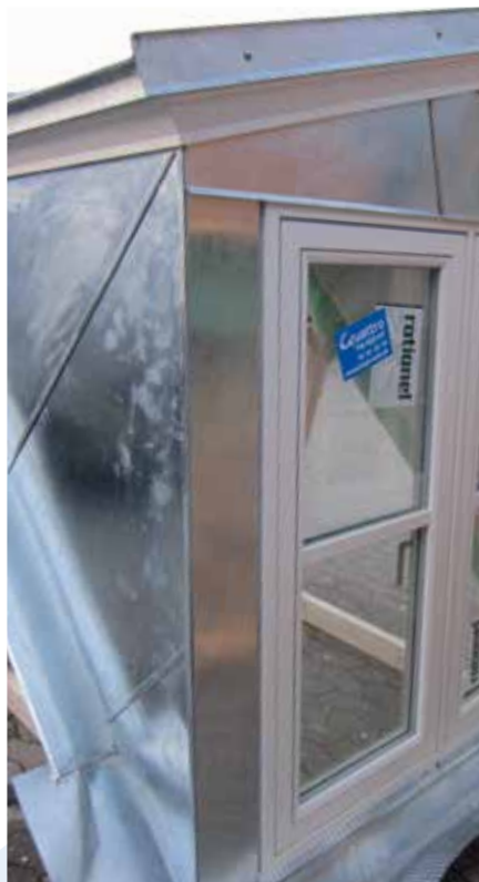
Zinkhjørnestolpe ved lukkede flunke og 95 mm skellet med superisolering \lambda 20. Herved bliver hjørnestolpen kun 111 mm.
