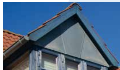
Zinkspejl og hakkebrædder
